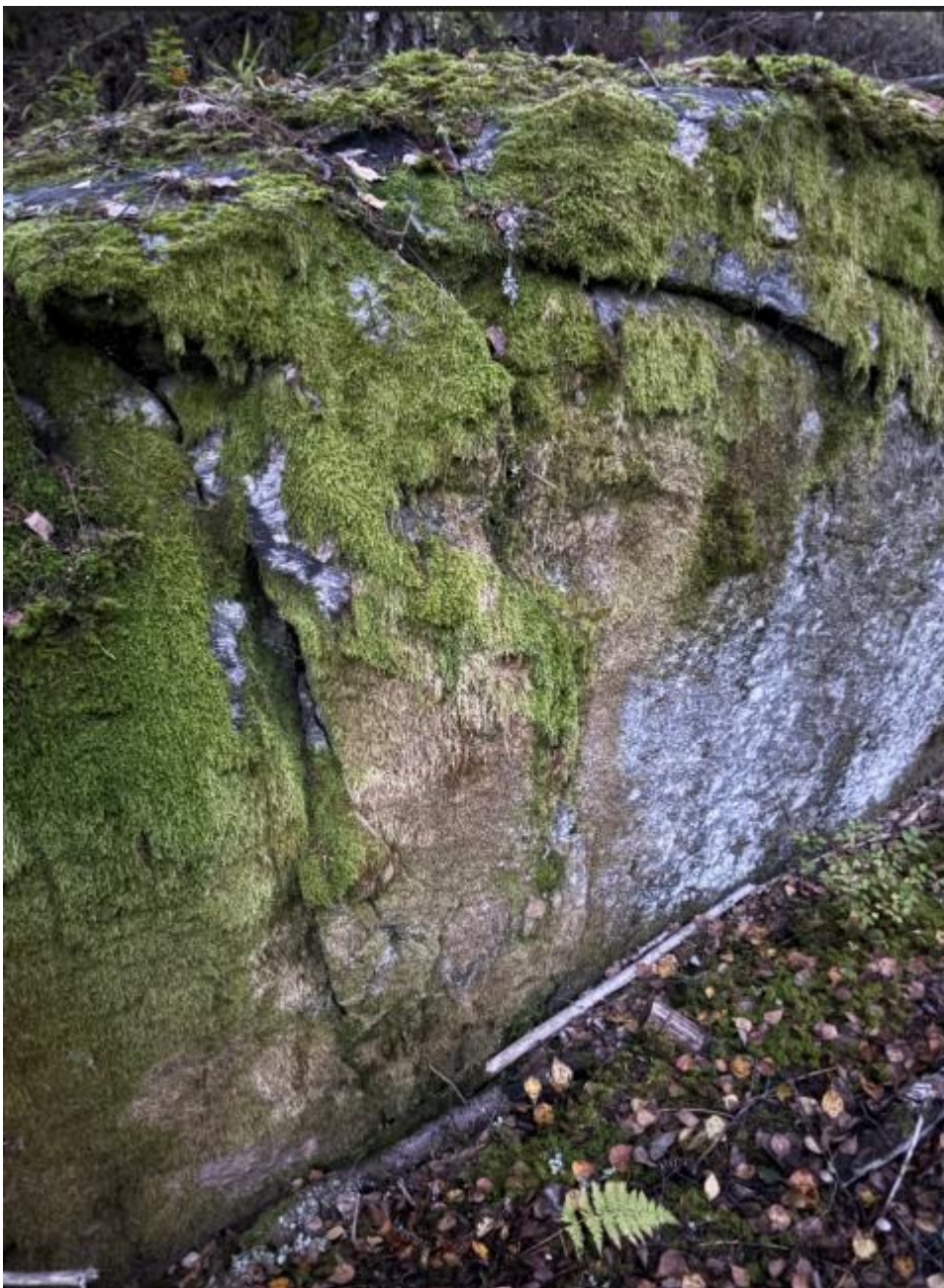
Kuva 9. Hankealueen kallioalueella oleva iso kivi, jossa on runsaasti halkeamia.
